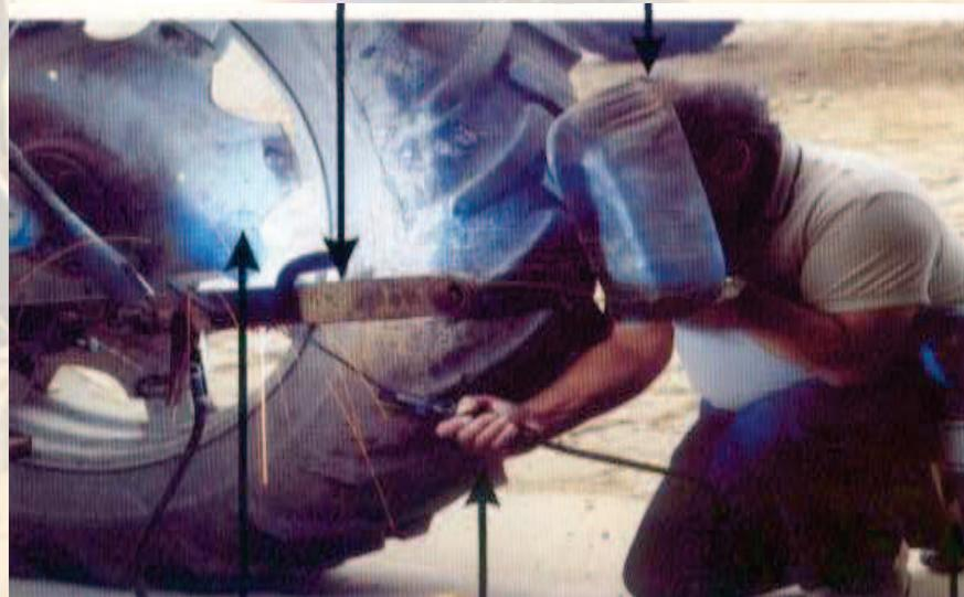
2. Prepare a peça a soldar por pontos. Para uma reparação deve chanfrar as bordas da peça a soldar.
