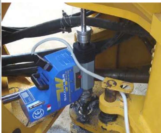
Renovação e realinhamento da articulação da carregadeira sobre esteiras. Intervenção realizada diretamente no local sem necessário desmontar até mesmo a mangueira hidráulica, eliminando o desperdício de óleo e respeitando o meio ambiente.
