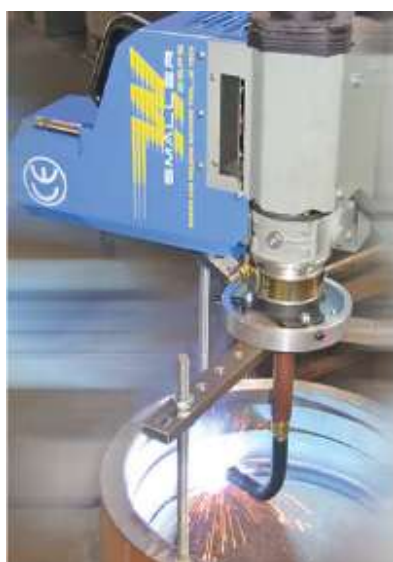
Enchimento por soldadura até Ø 380mm.
